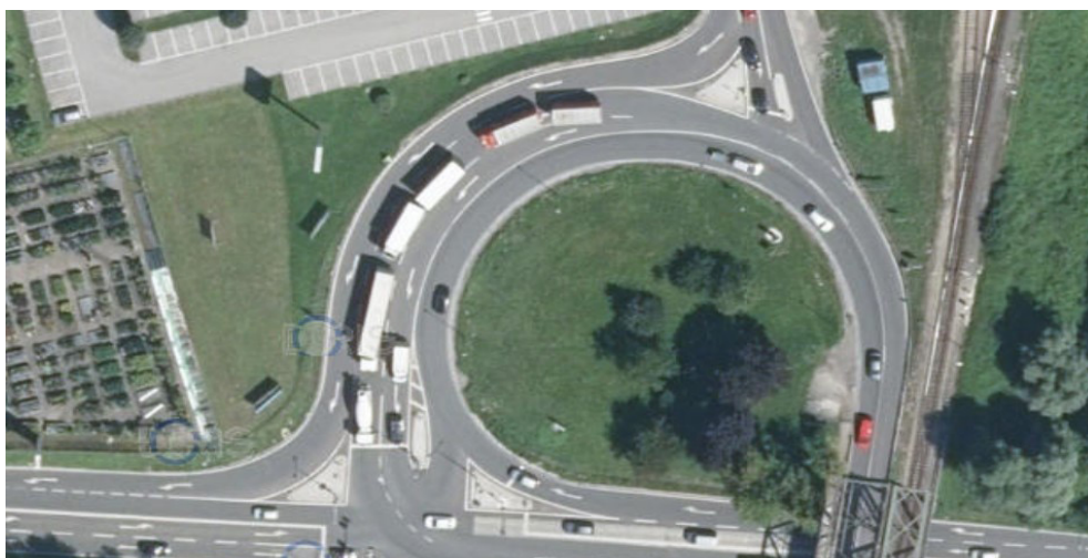
Neue Verkehrsführung 2020 mit zwei Linksabbiegestreifen
