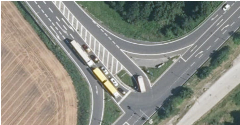
Orthofoto nach der Sanierung 2020 (Quelle Doris)
