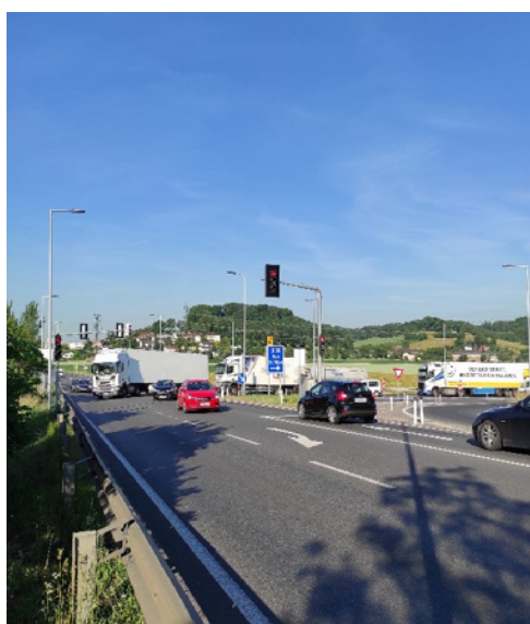
Bild li. AST Asten L566 Ipf Straße AST A1 in Asten mit zwei Linksabbiegestreifen, Beleuchtung und verkehrsabhängiger Ampelanlage Bild re. großzügige Beleuchtung des Knotenpunkts
