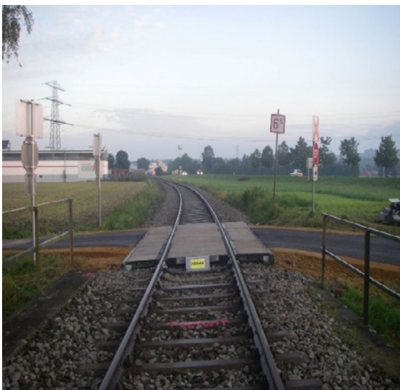
Eisenbahnkreuzung vor der Sanierung
