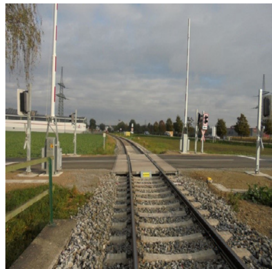
Eisenbahnkreuzung nach der Sanierung
