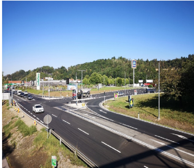
Bild li Entfernung der Mittelinsel Bild re neue Verkehrsführung ohne Mittelinsel
