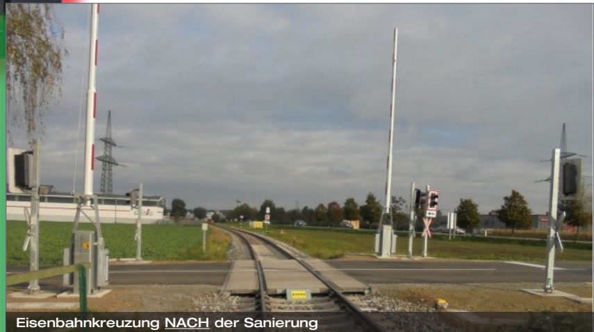
Eisenbahnkreuzung NACH der Sanierung
